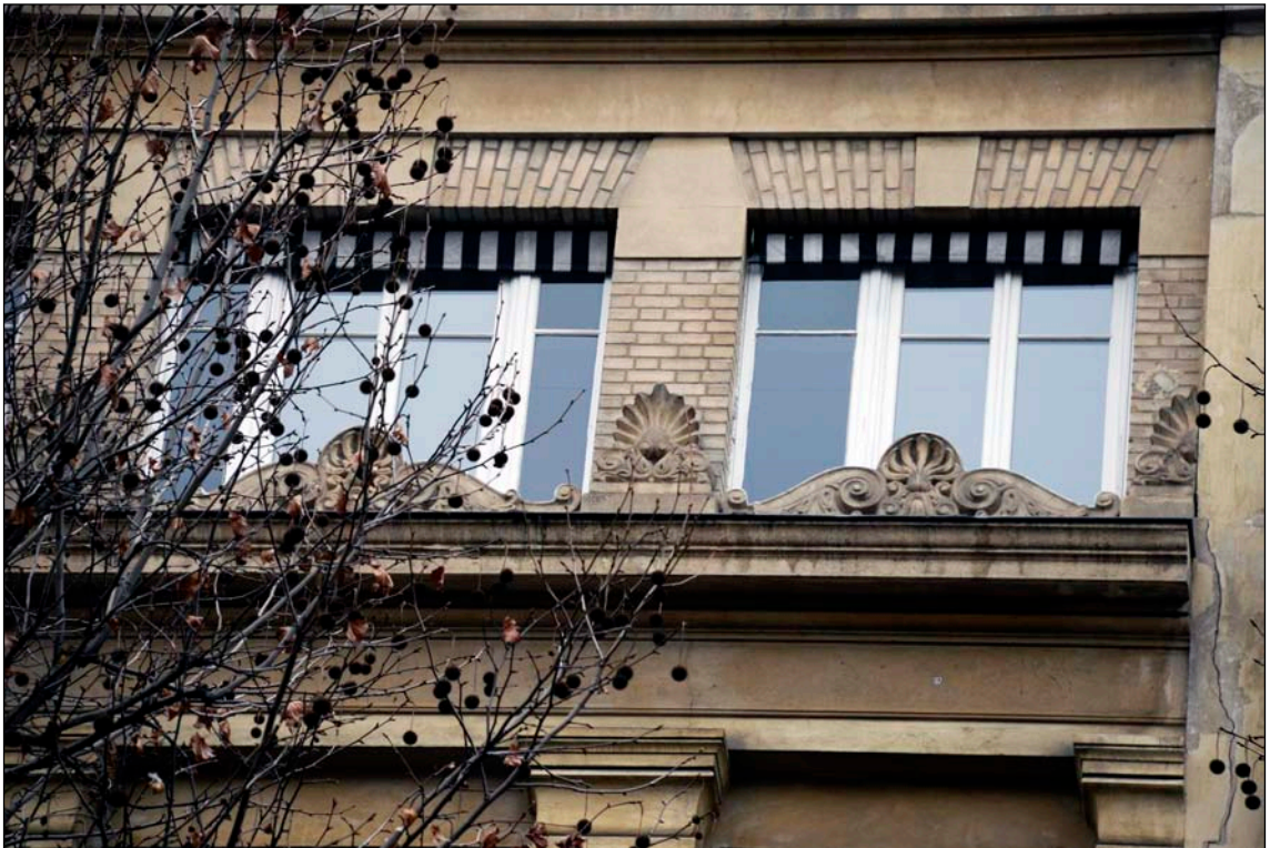
Boulevard Haussmann, 102, particolare delle finestre di un appartamento (Parigi, 2010)
